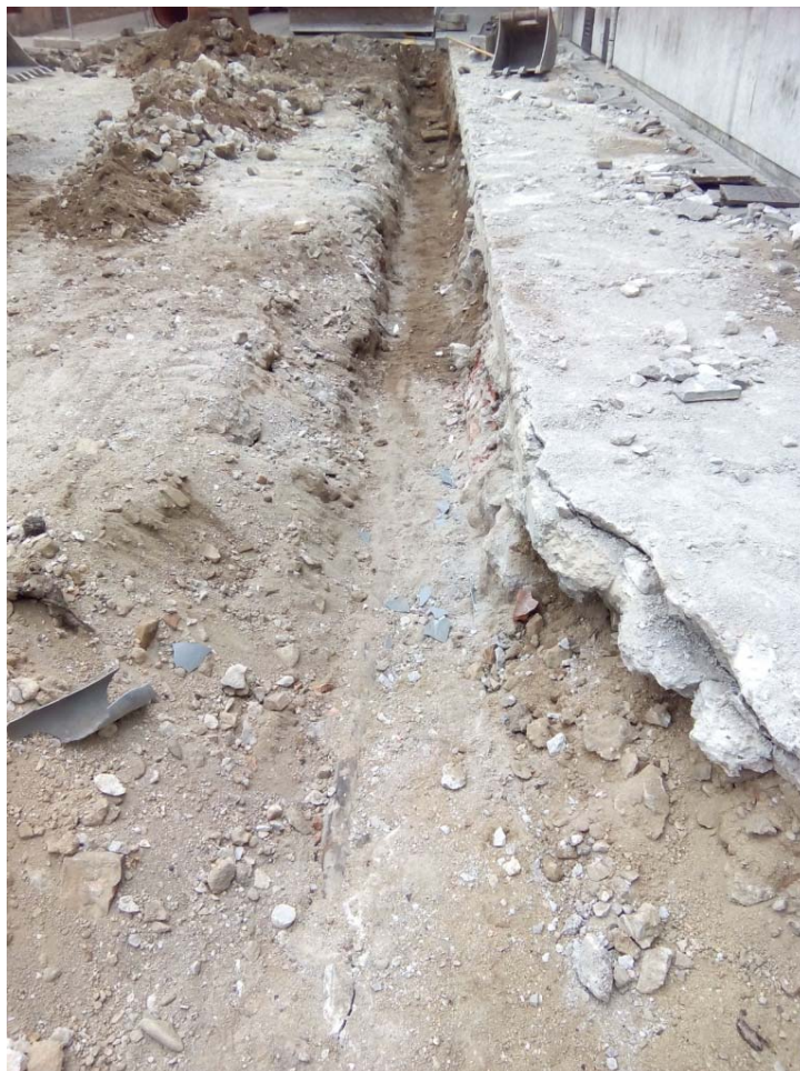
Vista de la rasa C.
