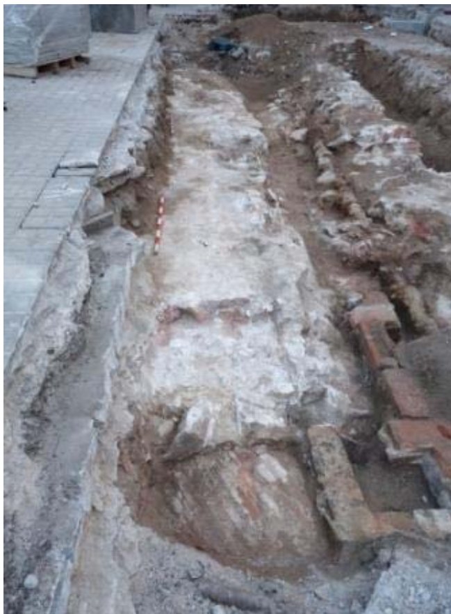
Vista de la coberta UE 103 i de la volta UE 104 en primer terme.
