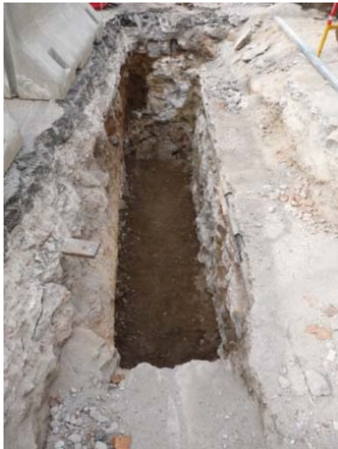
Vista de la rasa E després del desmuntatge del mur.
