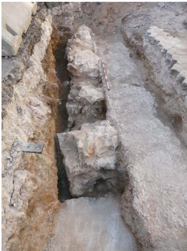
Vista de la fonamentació des de la cara est.
